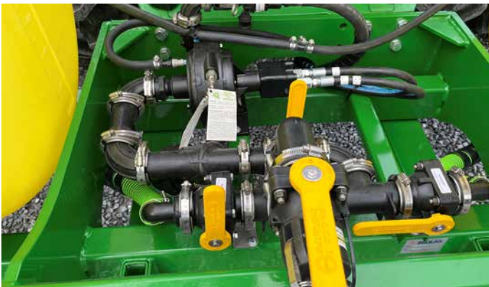
Installation pompe centrifuge wet seal avec chargement 2 pouces, plomberie pour application
